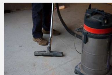
Obr. 1 – Čistenie podkladu
