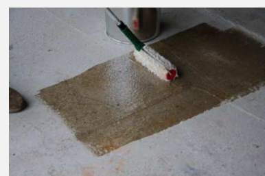
Obr. 3 – Aplikácia penetrácie
