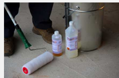
Obr. 2 – Penetrácia podkladu
